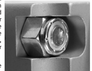
Abb. 21 Schraube ragt gerade über Bündigkeit hinaus
